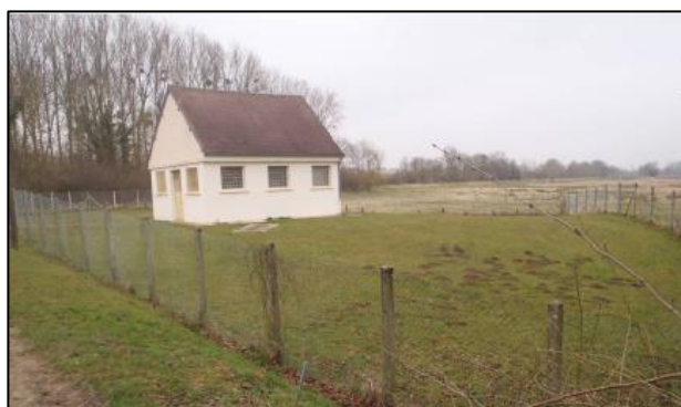
Station de pompage de Guiscard
