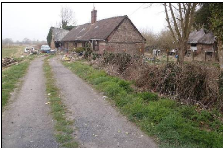
Ferme du chemin de l'étang
